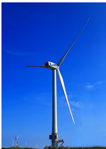
5,000kW 風力発電システム「HTW5.0-126」 (鹿島港深芝風力発電所)
